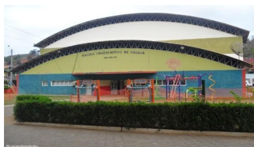
Figura 3-15 - Ginásio de Poliesportivo de Itarana.
