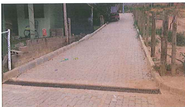
Ramo 800 – pavimentação e drenagem
