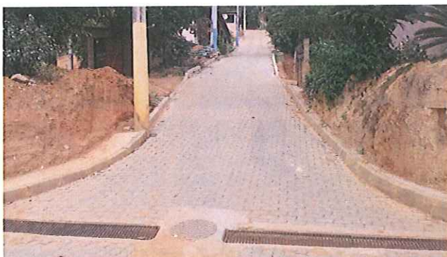
Ramo 700 – pavimentação e drenagem
