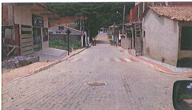
Rua Projetada – pavimentação e drenagem
