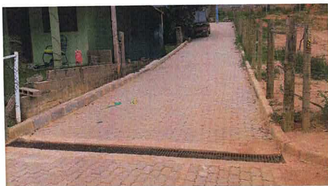
Ramo 800 – pavimentação e drenagem
