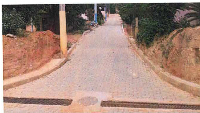
Ramo 700 – pavimentação e drenagem
