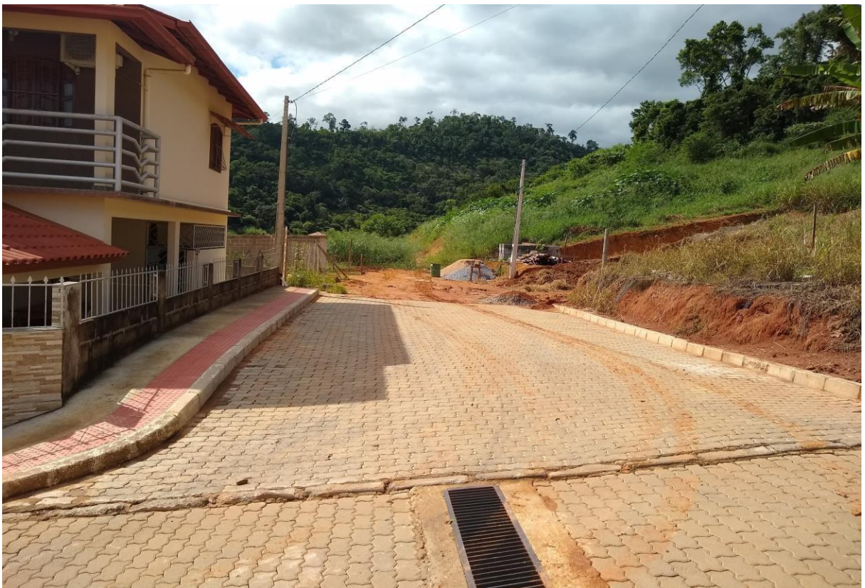
Pavimentação, construção de calçada.
