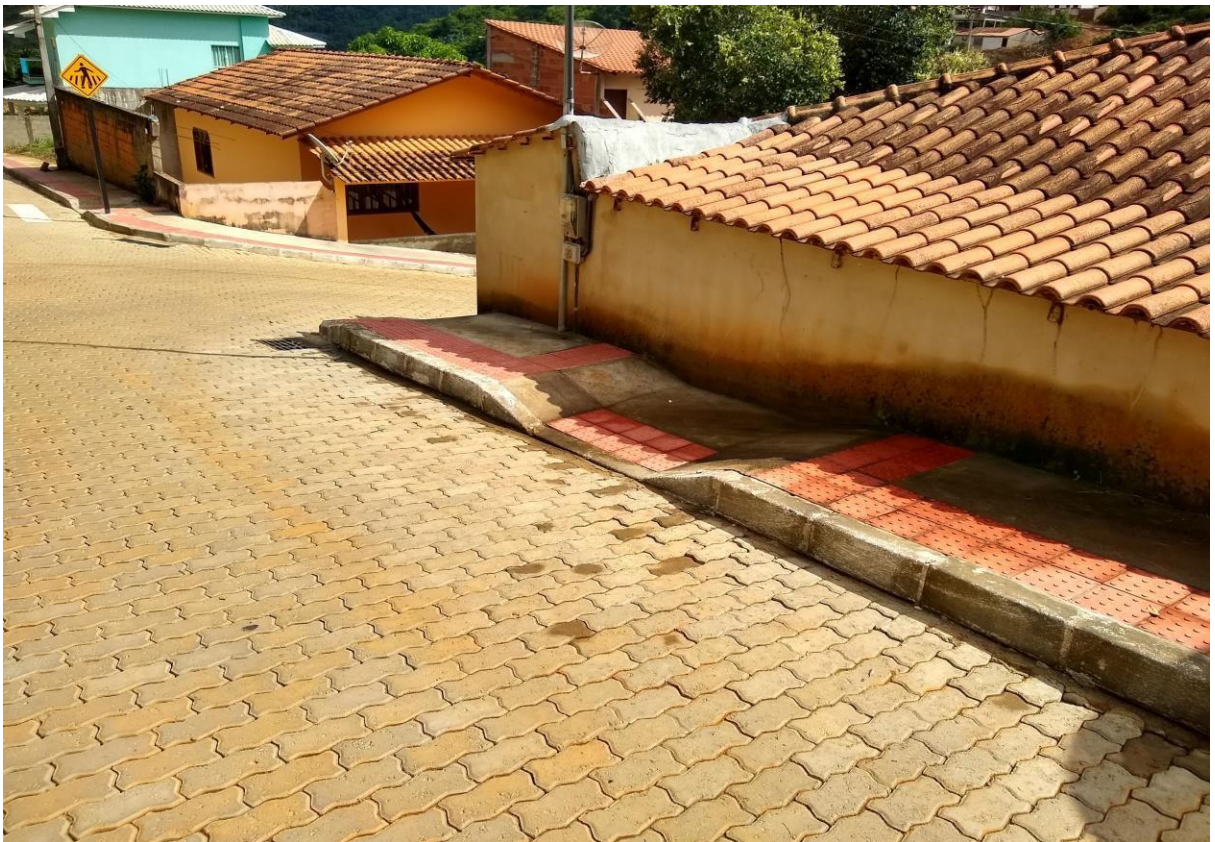
Pavimentação, construção de calçada e acessibilidade
