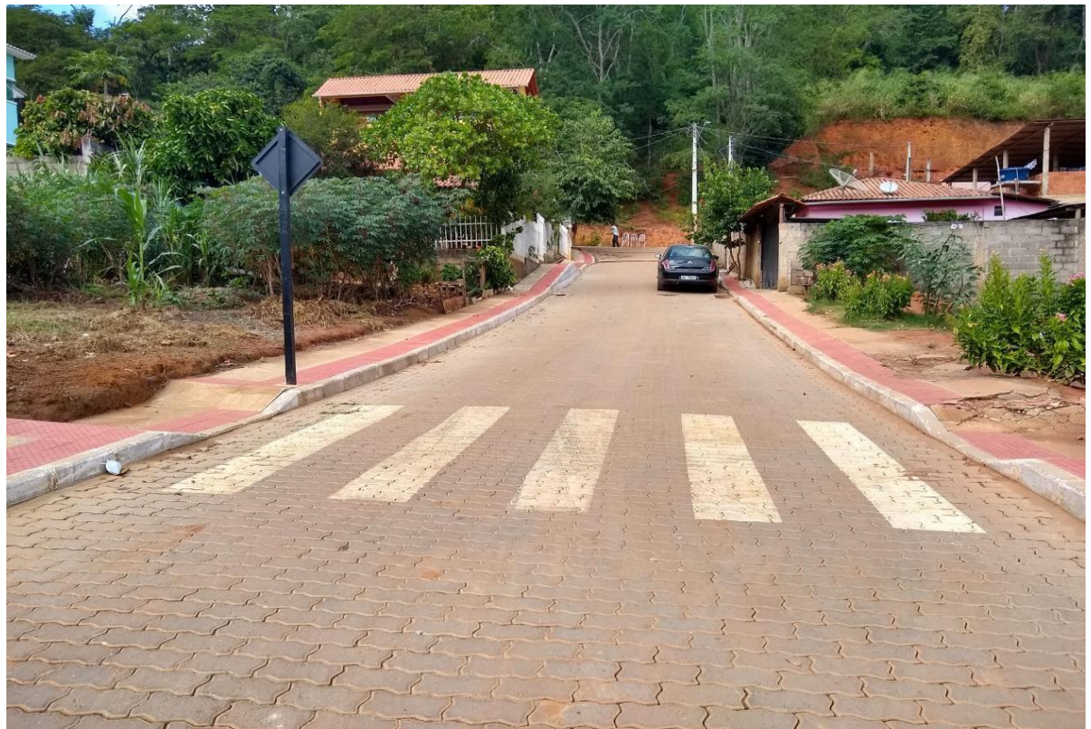
Pavimentação, construção de calçada e sinalização
