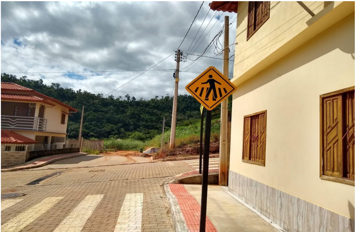
Pavimentação, construção de calçada e sinalização
