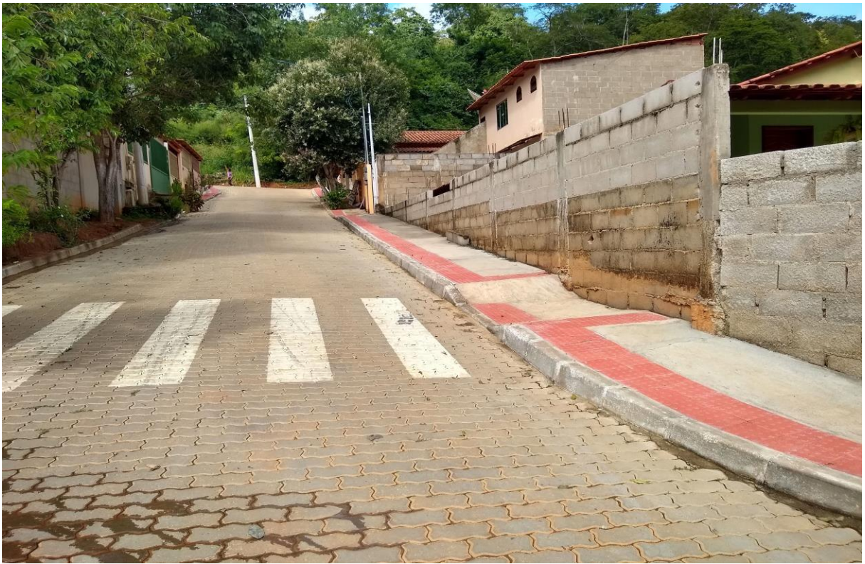
Pavimentação, construção de calçada e sinalização
