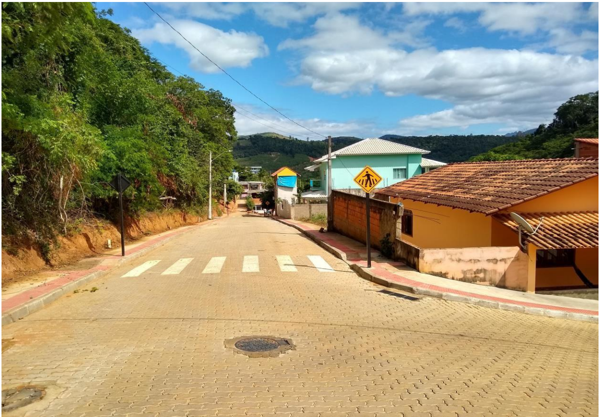
Pavimentação e drenagem
