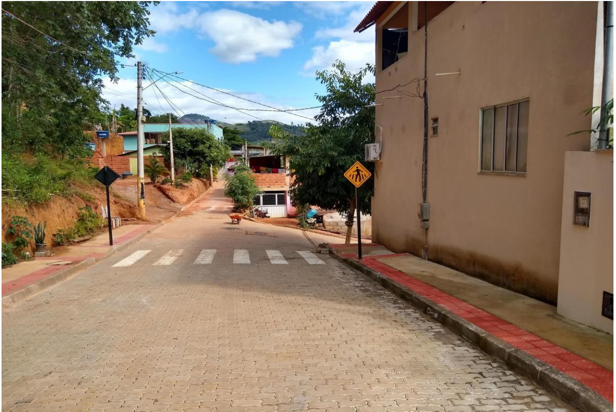
Pavimentação, construção de calçada e sinalização
